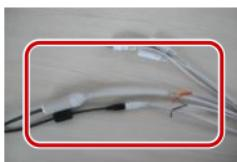
⑧ 对连接电缆做好绝缘防护。
